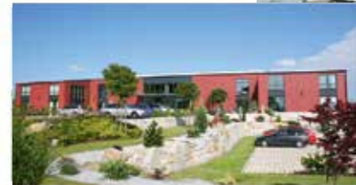
WOLF System Bauherrenstudio Osterhofen - Die Ausstellung rund ums Bauen
