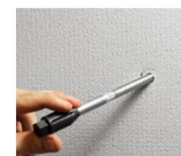
Einsetzen des Dübels Thermax 10/60 in das Bohrloch
