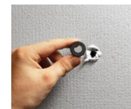
Bohrloch mit ausreichend Dichtstoff
