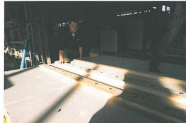
Abbildung 4: Verschraubung der Tragkonstruktion
