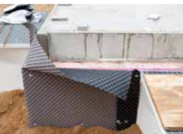
Dämmung Außenwand Keller
