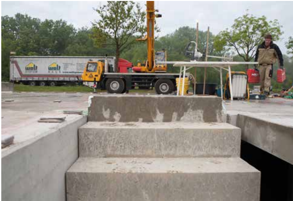
Bauseitige Kellertreppe eingebaut
