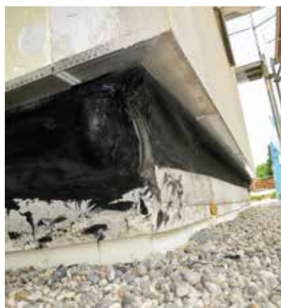
Dämmung Außenwand Keller
