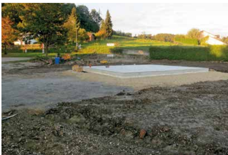
Fertige Bodenplatte
