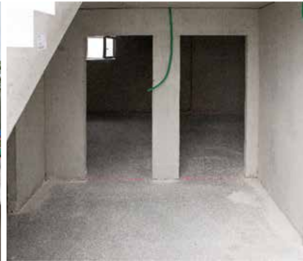
Keller frei von Nässe
