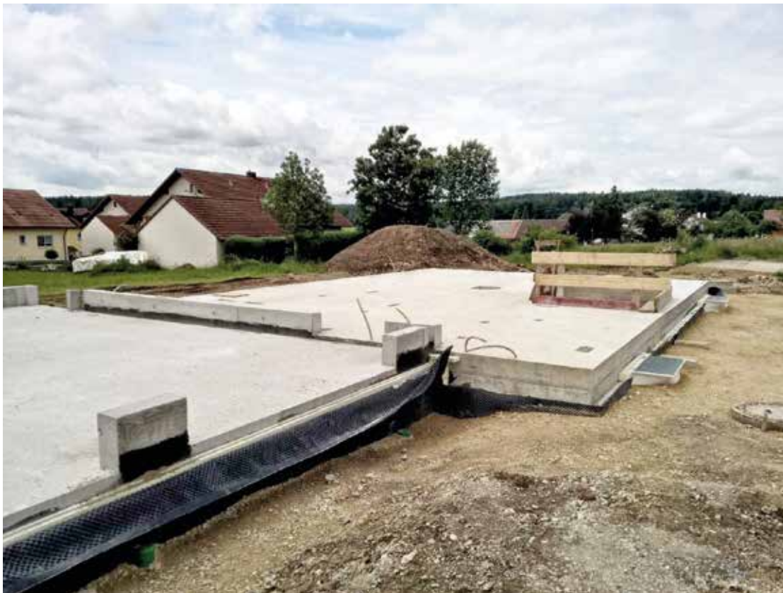
Absturzicherung um Treppenloch
