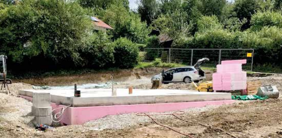
Dämmung um Bodenplatte – Streifen oben freigelassen
