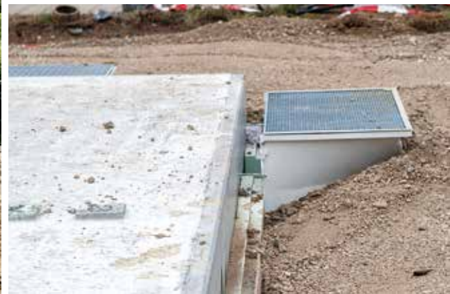
Dämmung oben ausgespart
