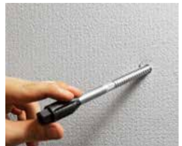
Einsetzen des Dübels Thermax 8/60 in das Bohrloch
