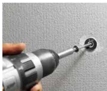
Vorgebohrtes Loch an der Fassade
