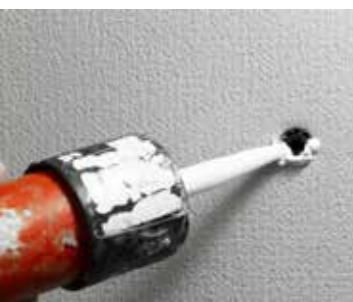
Abdichten des Dübelskopfes im Bohrloch mit StoSeal F 505
