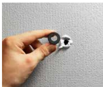
Bohrloch mit ausreichend Dichtstoff
